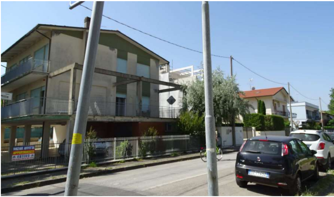
Foto 14 – Fabbricati residenziali, posti su Viale dei Mille
