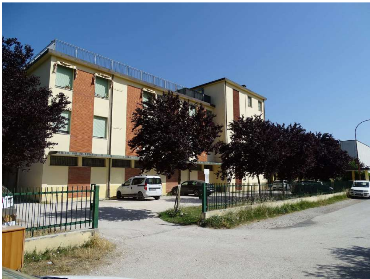
Foto 11 – Fabbricato residenziale, presa fotografica lato Parco di Levante da Viale dei Mille
