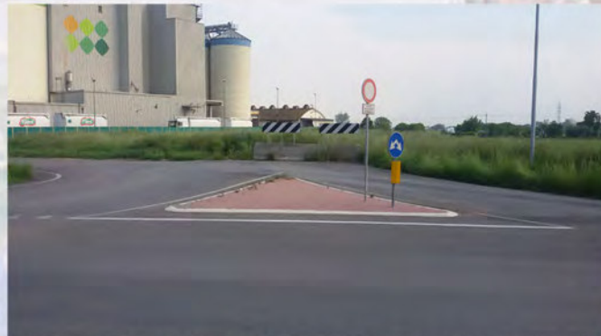
INNESTO DELLA NUOVA STRADA (VISTA DA VIA EMILIA)
