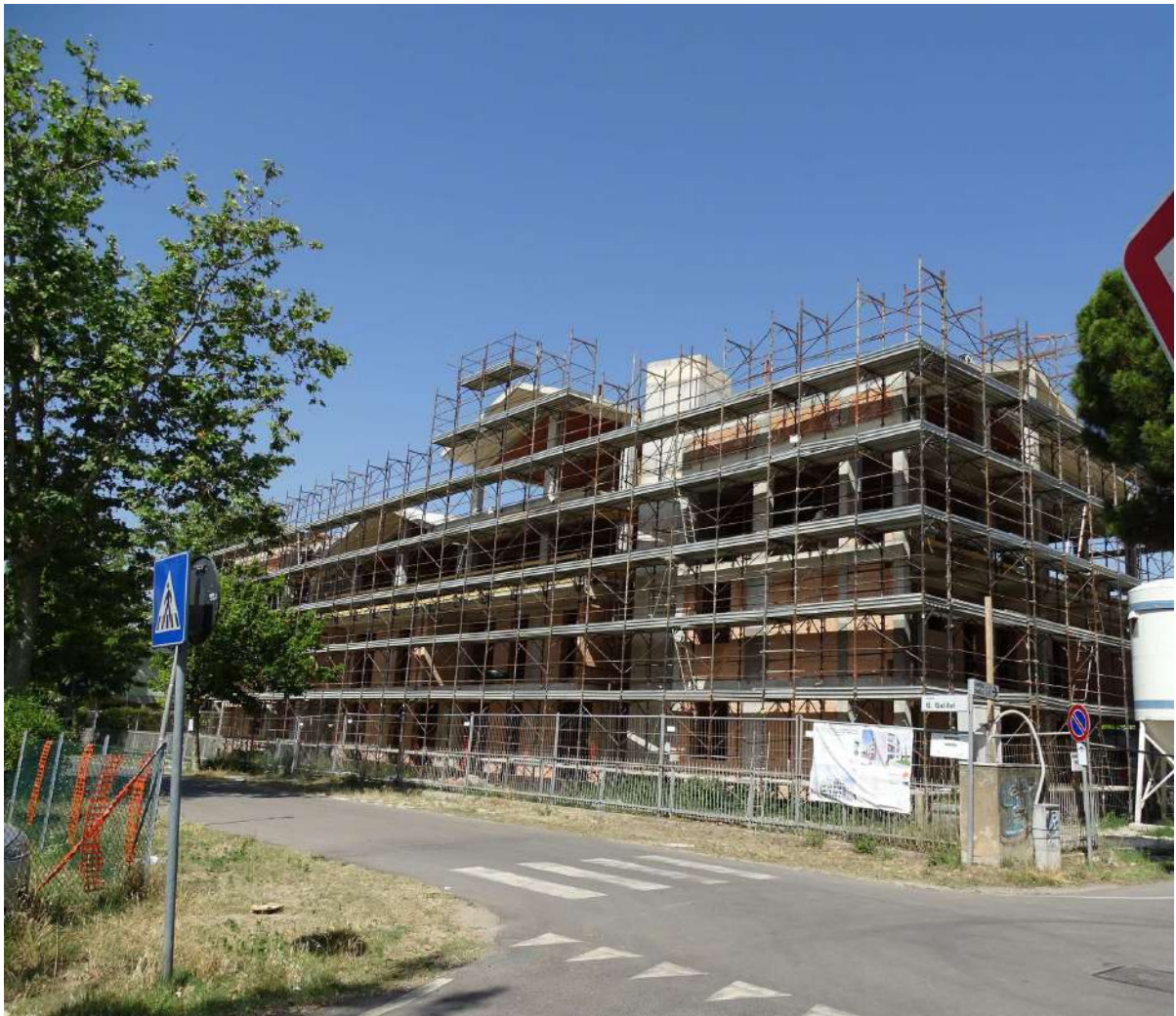
Foto 7 – Struttura Residenziale E.R.P., in costruzione, presa scattata tra angolo Viale G. Galilei e Viale Pitagora
