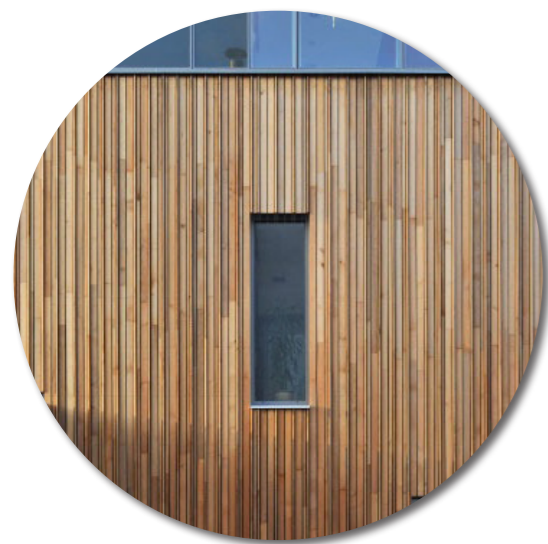
RIVESTIMENTO IN LEGNO A DOGHE VERTICALI
