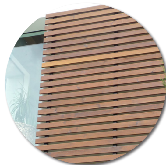
RIVESTIMENTO A DOGHE IN LEGNO SU SOTTOSTRUTTURA
