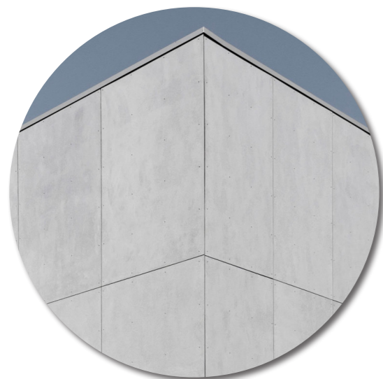
RIVESTIMENTO IN LASTRE DI FIBROCEMENTO
