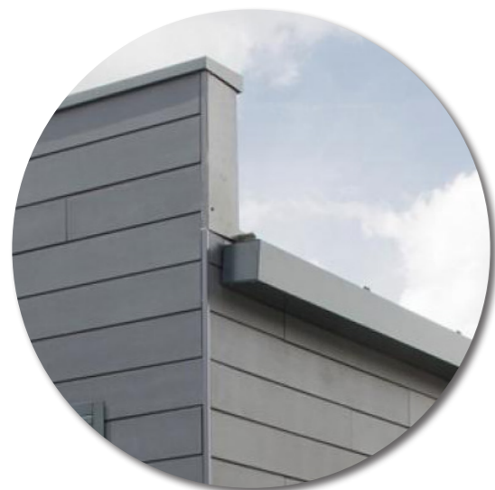
RIVESTIMENTO A DOGHE IN FIBRO CEMENTO
