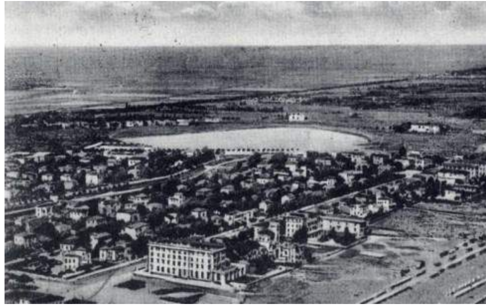
Figura n. B.3.III - Il centro balneare con il Grand Hotel dall'aeroplano - anni Quaranta. Sullo sfondo, oltre il bacino di ripulsa, la zona di Ponente priva di costruzioni con la sola costruzione Ospizio Marino Cremonese
