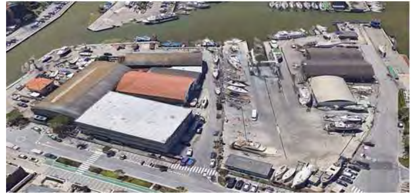
Figura n.B.2.XI - Vista aerea cantieri navali
