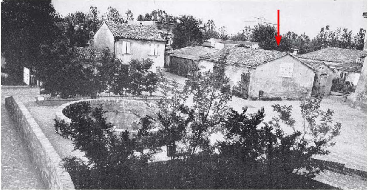
Foto dell'area prima degli interventi di recupero
