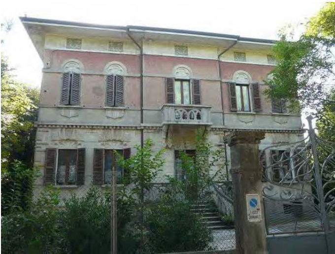
foto 03 La villa prima degli interventi di restauro
